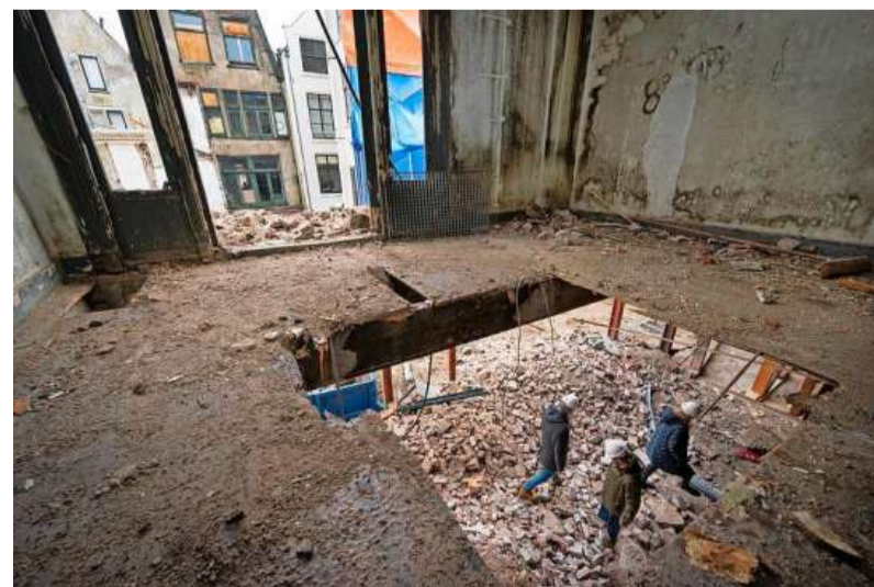
Doorkijkje bij de sloop.
